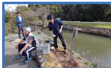
河川監視カメラの設置状況
